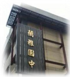
造型牆損壞整修
