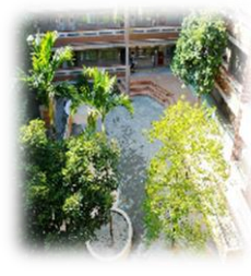
耐震能力補強工程
